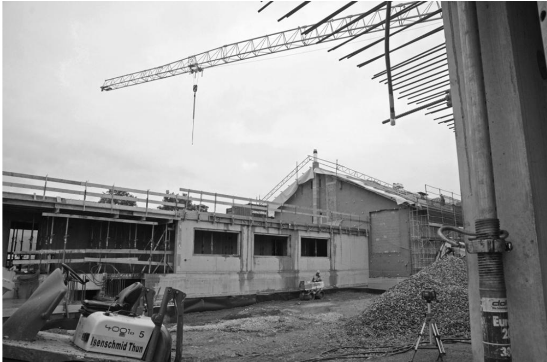
Baumeisterarbeiten: Die Baumeisterarbeiten sollten Ende Oktober beendet sein.
