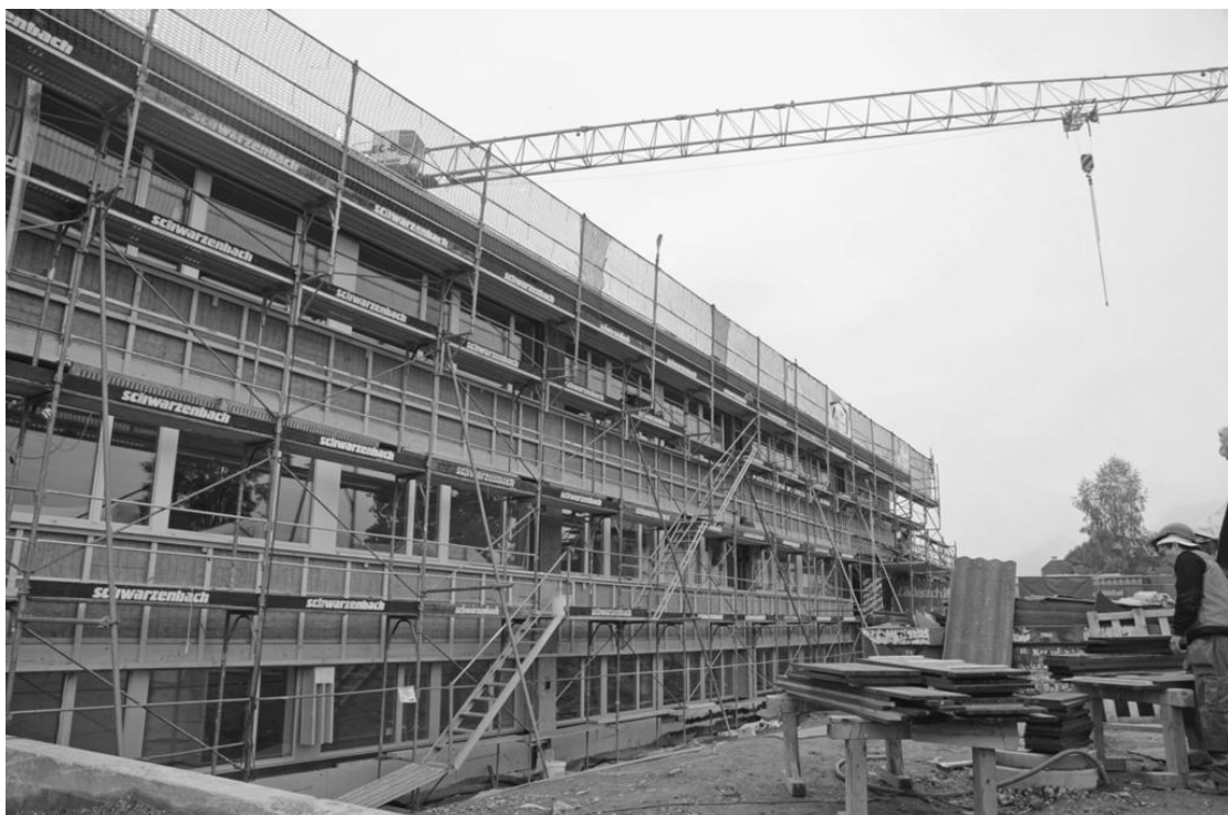
Energetische Sanierung: Am bestehenden Schulhaus wurden die Fassaden zusätzlich gedämmt und die Fenster erneuert.
